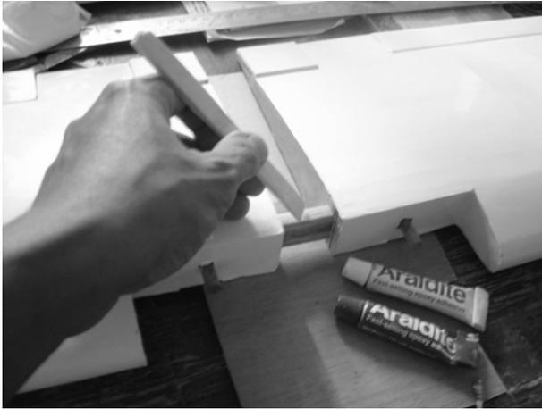
Oleskan lem epoksi yang sudah dicampur 1:1 ke Central Joiner, lubang spar dan rib-rib sayap tengah yang saling berhadapan sehingga hasilnya akan diperoleh sayap yang kokoh, rapi, lurus, tidak twist dan tidak mudah patah.
